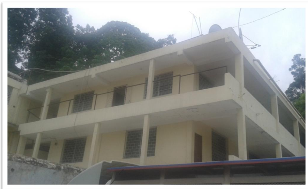
▲. Comunidad de San Gerardo en Carrefour –Feuilles (Puerto Príncipe) donde se instalarán 36 módulos de 190W.
