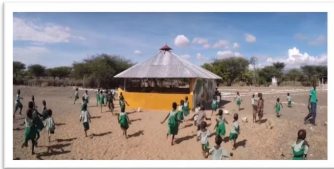
Infraestructura de una Unidad Nutricional
