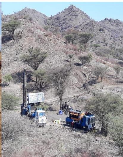
Llegada de camiones y máquinas
