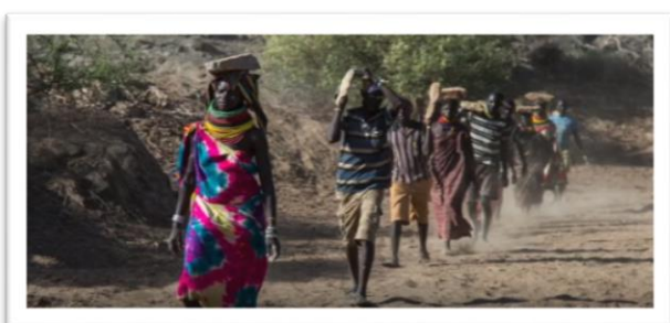
Participación de las mujeres en la construcción de la presa
