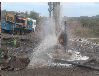
Momento de salir de agua en la perforación
