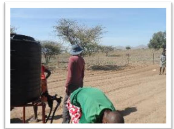
Instalación sistema de riego por goteo (huerto comunitario en Kokuselei)
