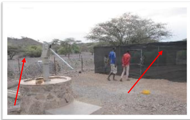
Valla mejorada, vivero (pozo Lokuakipi, Ebur, perforado en 2015)
