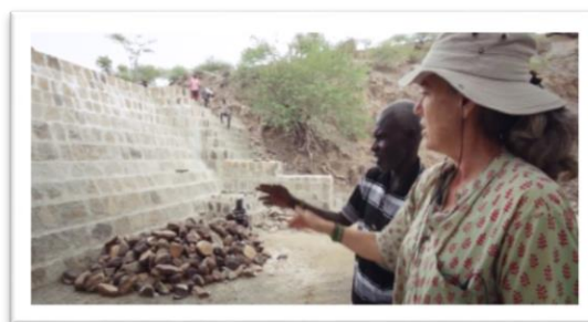
Misionera de la CMSPA comprobando las obras de una presa de piedra
