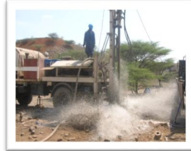
Perforación pozos profundos
