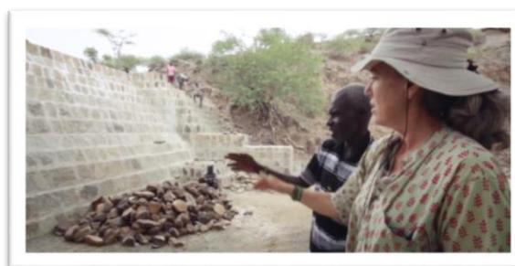
Misionera de la CMSPA comprobando las obras de una presa de piedra
