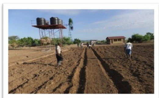
Tanques de almacenamiento de agua
