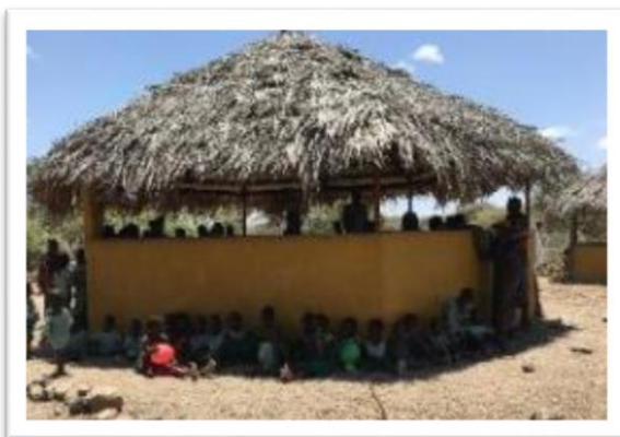
Foto de la parte exterior de un aula-sombra
