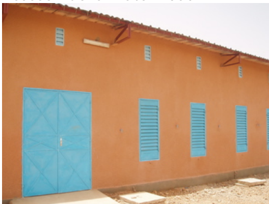
Finalización nueva maternidad
